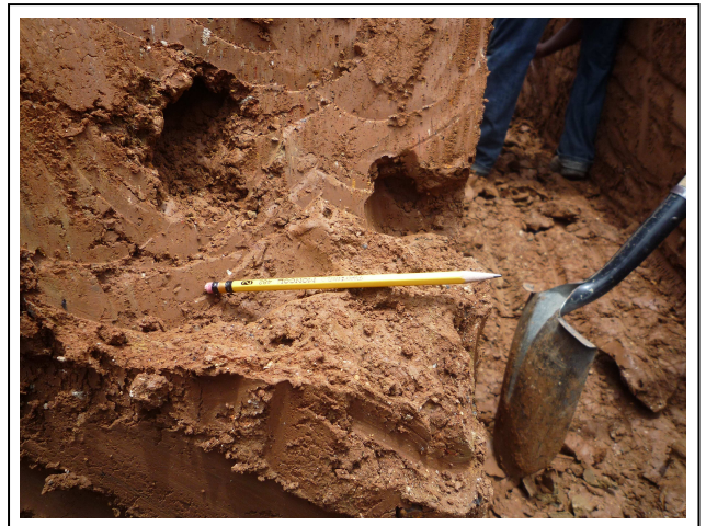
Imagen 02. Vacíos presentes en terraplén de prueba
