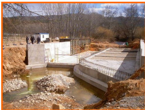
Construcción de estación de aforos en el Río Turia
