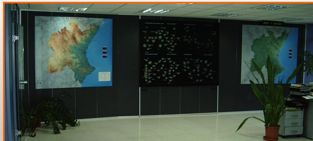
Sala de control del SAIH Júcar
