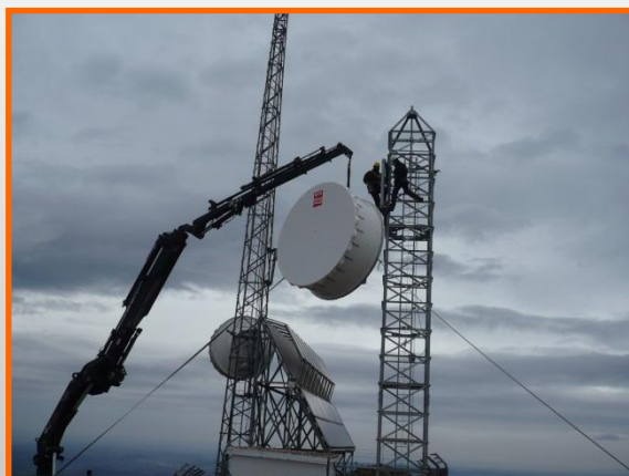
Instalación de torre y antena para enlace de microondas
