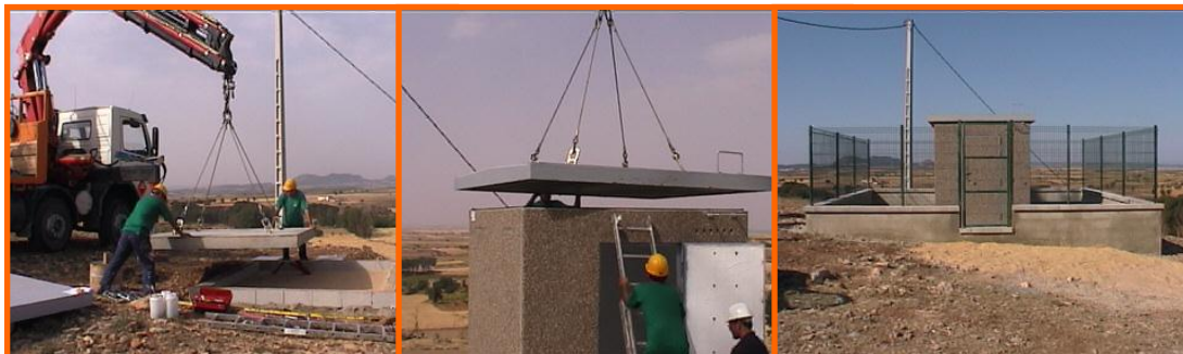
Instalación de una caseta para punto de control
